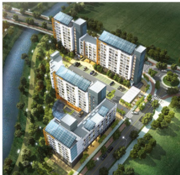
[그림] 공동주택 히트펌프 적용 시범단지 (세종)
