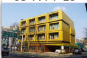
공릉 기숙사 리모델링
