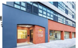
청년 특화형 매입임대주택 사례 (노후 관광호텔 리모델링) 인입생원, LH+아이부키
