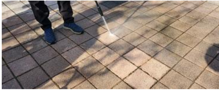
[고압세척기를 이용한 투수블록 표면 세척]
