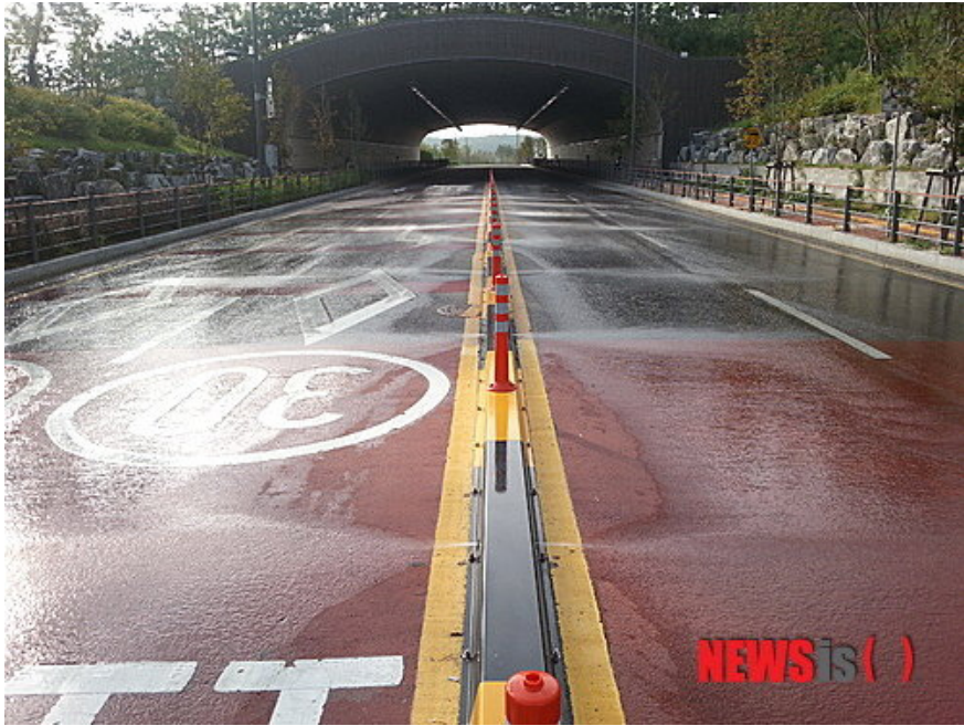
[그림 2-18] 빗물을 이용한 노면 살수 및 융설 시스템 (뉴시스, 2013.11.07)
