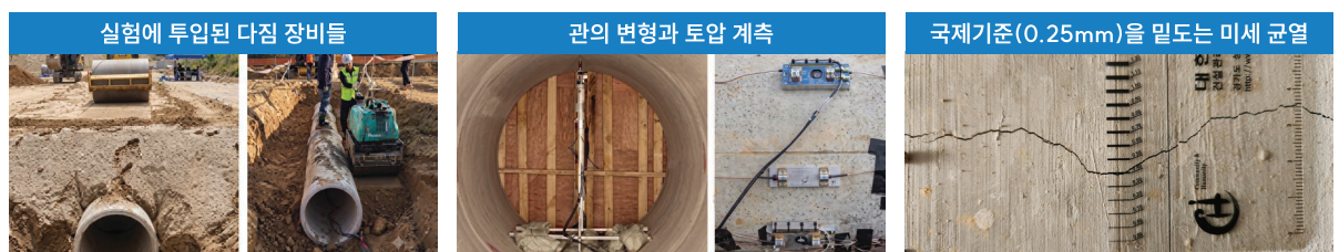
그림-4 관 위에 얼마나 얇게 흙을 덮어도 될까, 현장 실증실험 구성 및 검증 현장
