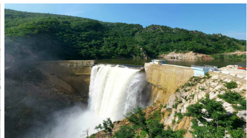
언제와 발전소 외부 전경
