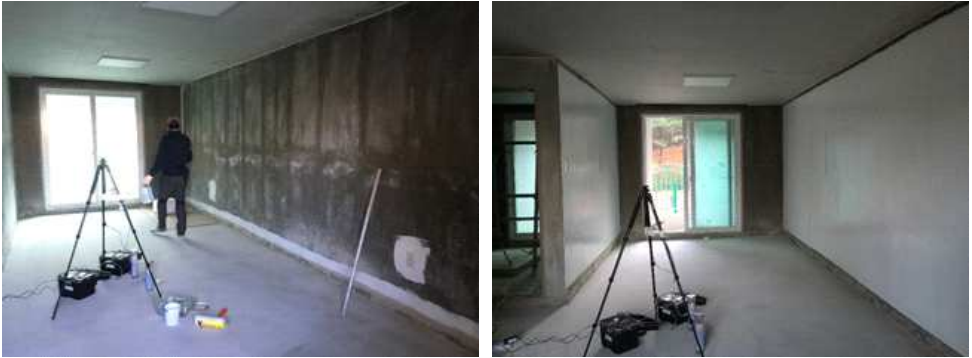
[그림 3-24] 실증주택 도료 시공 및 실내 라돈 농도 측정
