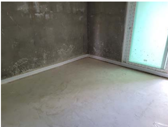
(b) 완충재 설치(좌:측면완충재, 우:바닥 완충재)
