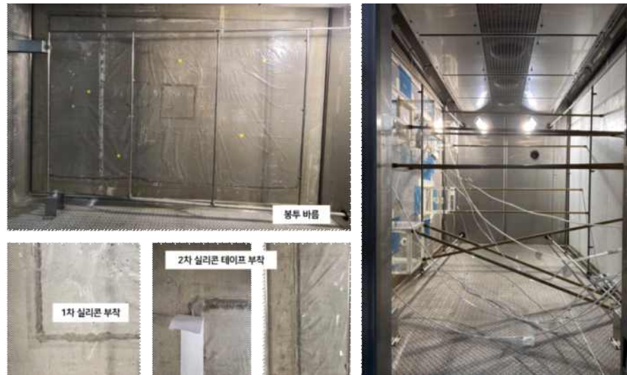
[그림 4-43] Mock-up PE 필름 시공 및 챔버 부착
