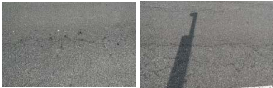
[그림 3.10] 5-2구간 표면상태 모습((左) 종방향균열, (右) 거북등 균열)
