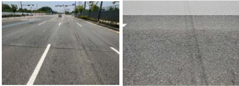
[그림 3.5] 5-1구간 표면상태 모습((左) 소파보수(Patching), (右) 거북등 균열)
