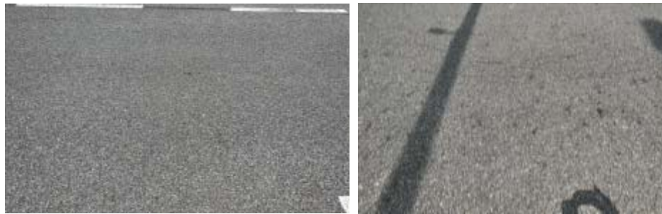
[그림 3.6] 3구간 표면상태 모습((左) 전반적인 표면 상태, (右) 종방향 균열 모습)
