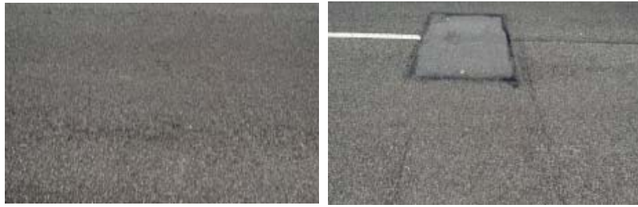
[그림 3.9] 4구간 표면상태 모습((左) 종방향균열, (右) 횡방향 균열 및 소파보수)
