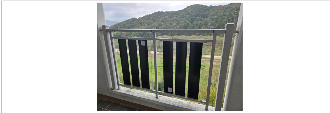
[그림 5-9] 주동 옥상 및 단지 펜스 적용이 가능한 외부 난간형 BIPV 시스템
