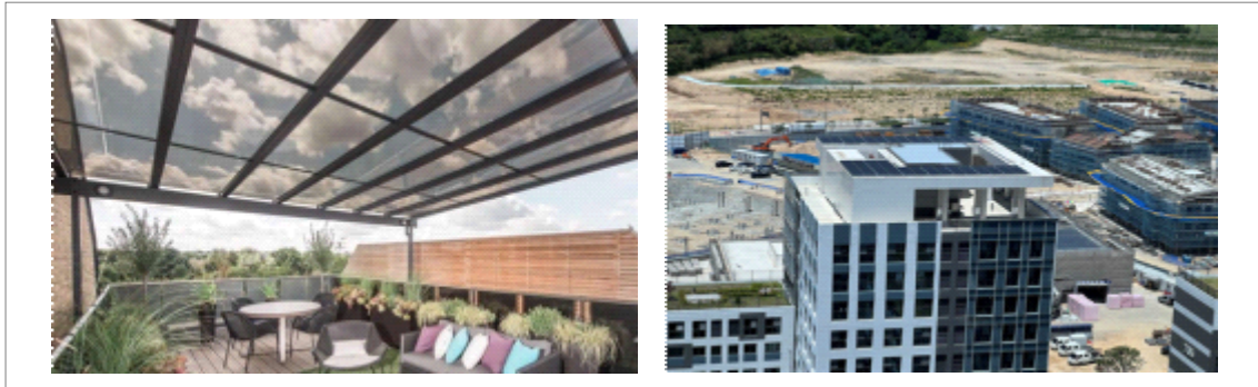
[그림 5-5] 옥상 구조물을 활용한 태양광 발전 설치 사례 (좌) 태양광 발전 캐노피, (우) 태양광 옥상 지붕
