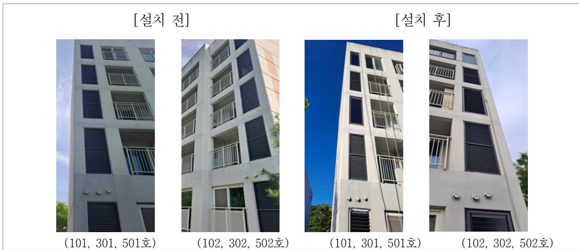
[그림 4-14] 에어컨 실외기실 루버 설치 전/후 모습
