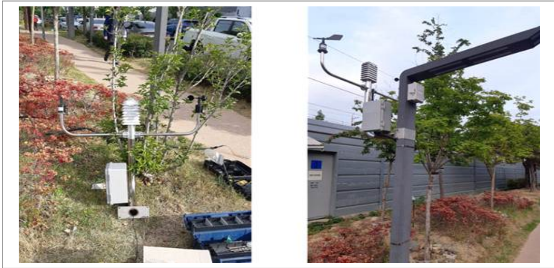
[그림 3-8] 환경 센서(좌)와 폭염 저감 장치 제어기기 설치(우)
