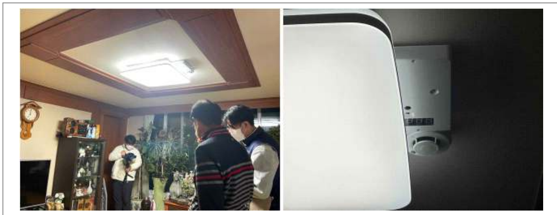
[그림 3-24] 스마트 화재경보 LED 조명등 실제 적용 사례
