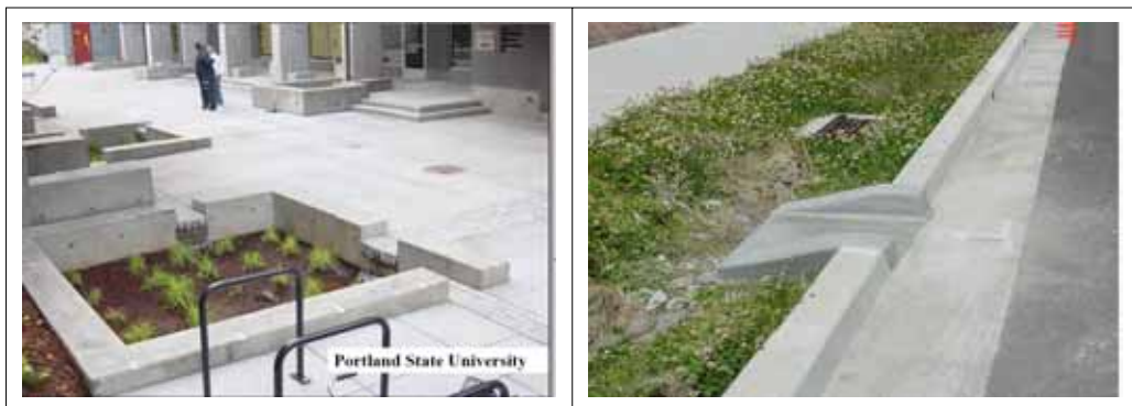
(그림 5-33) 저류형 화단 개념도(좌)와 물대물데 시스템(우)
