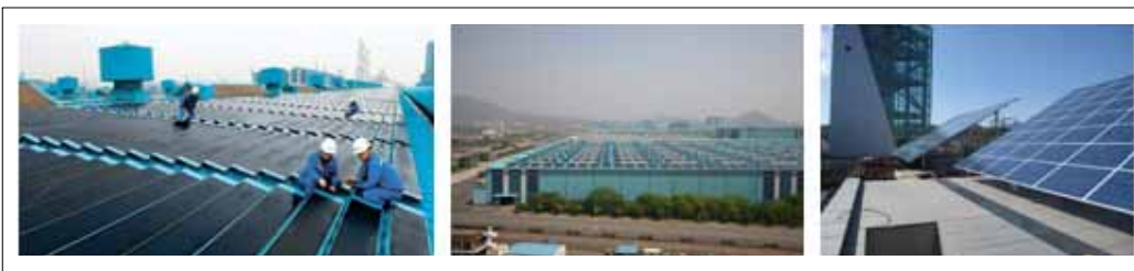
〔그림 5-69〕 산업단지 내 태양광 발전 패널 설치 현장
