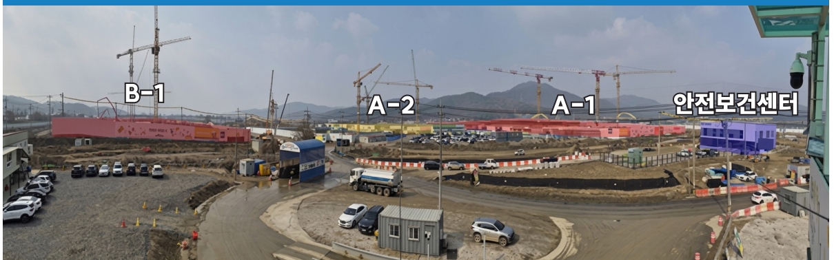
[현장 느낌] 남양주 왕숙 신도시 공사 현장 전경
