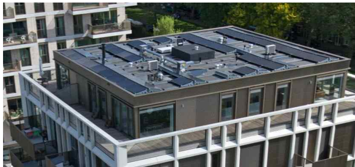
[그림 3-74] 옥상 태양광 패널 설치
