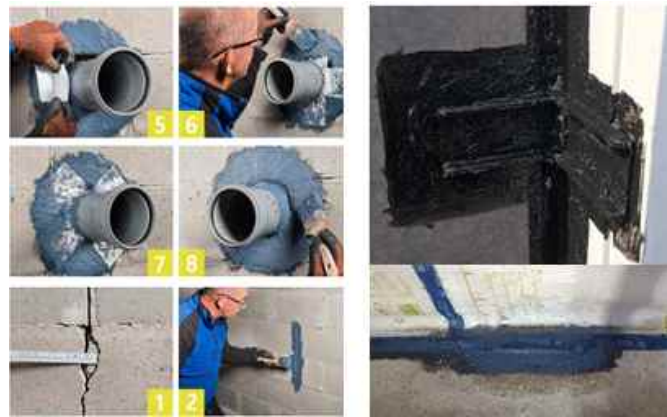
[그림 4-4] 틈새부위에 적용 가능한 도장형 기밀자재 적용 예시
