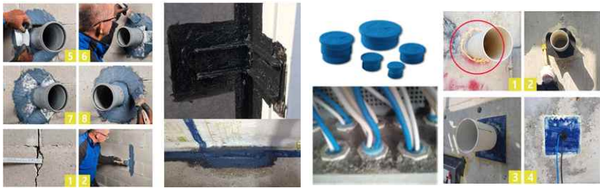
[그림 3] 틈새부위에 적용 가능한 도장형 기밀자재 예시 [그림 4] 배관에 적용 가능한 기밀자재 적용 예시
