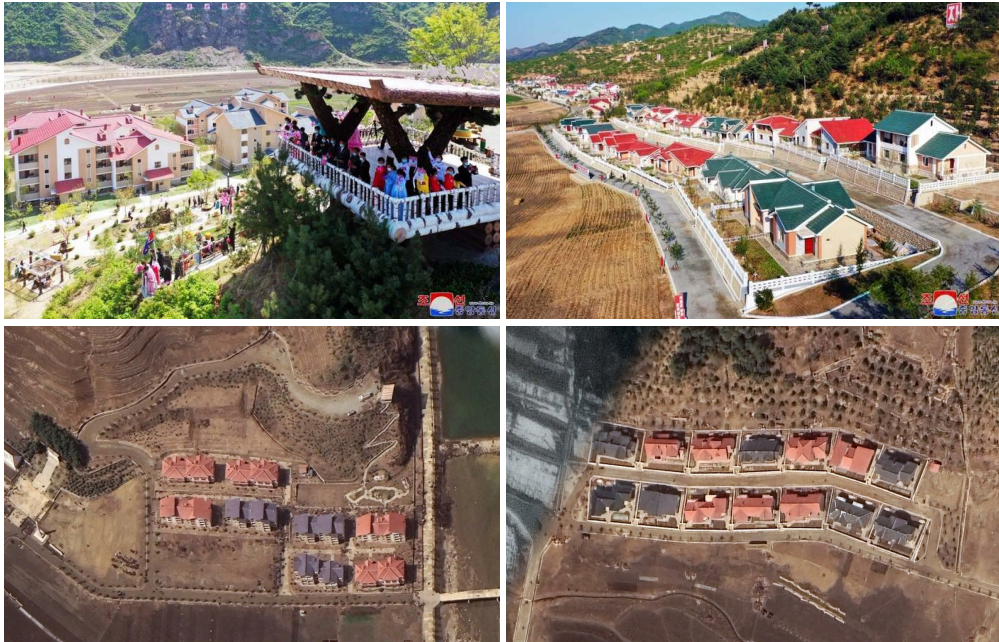
그림 7 지산농장 주택준공 모습(1동 6세대 아파트, 1동 2세대)
