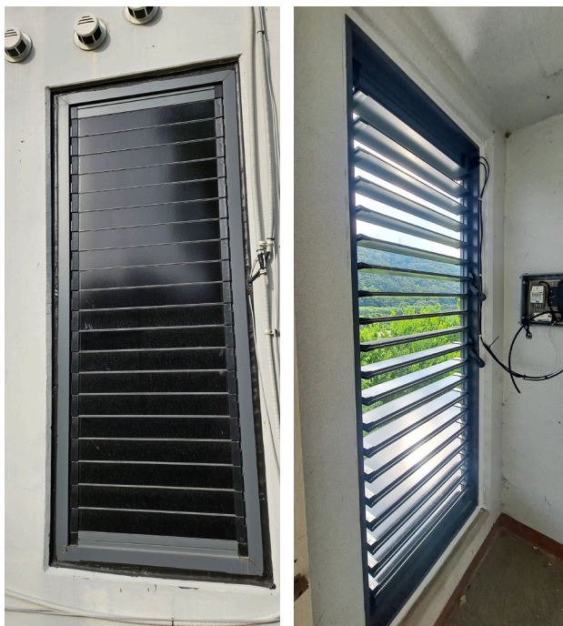
그림-4 BIPV 루버 설치 모습
