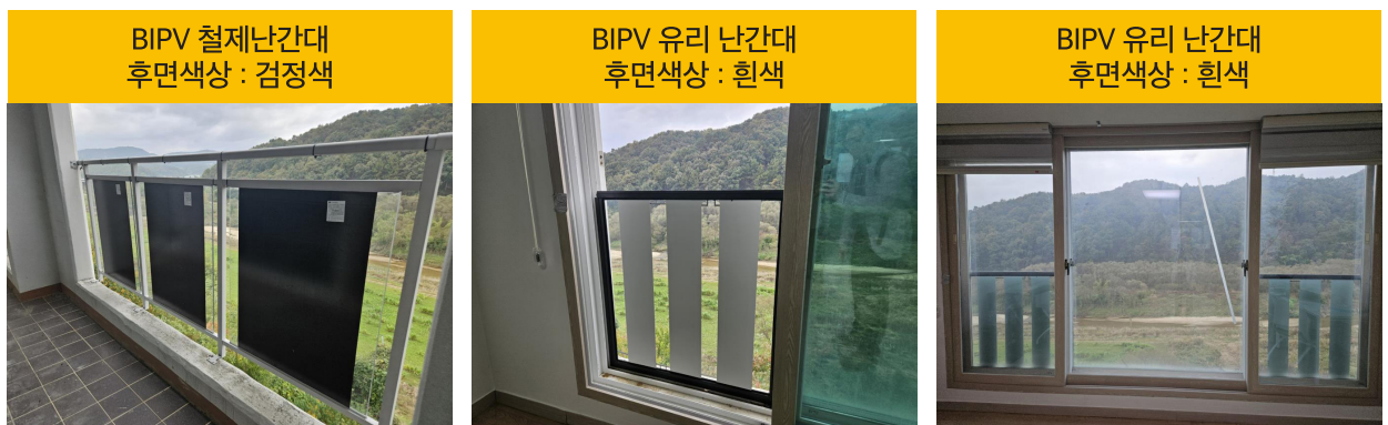
그림-6 BIPV 난간대 후면 색상 다양화
