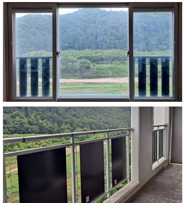
그림-5 BIPV 난간대 설치 모습
