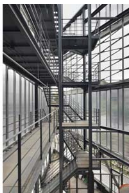
[그림 6-15] Herma Parking Building의 자연통풍에 용이한 구조
