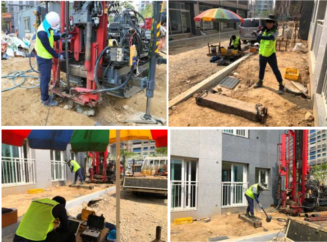
[그림 4.6] 화성봉담 다운홀 테스트 현장사진
