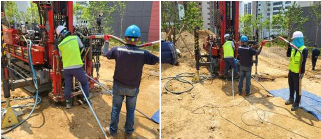
[그림 4.17] 파주 운정 부유식 음파검층 현장사진
