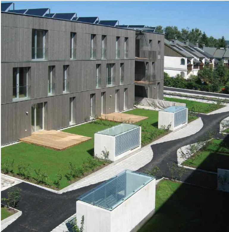
[그림4-71] 단지전경 - 자연환기방식의 지하주차장
