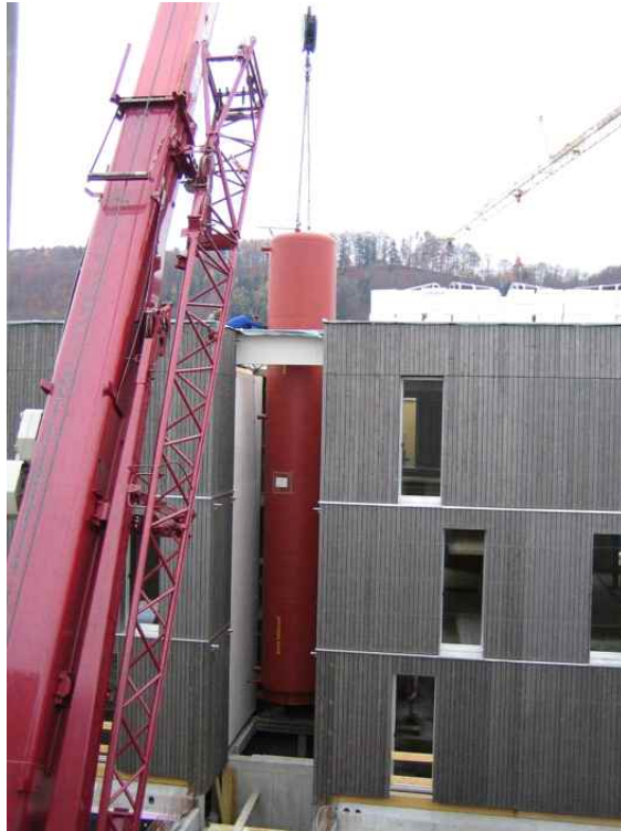
[그림4-71] 중앙건물 발코니 로지아 뒤편에 보온부퍼탱크 설치
