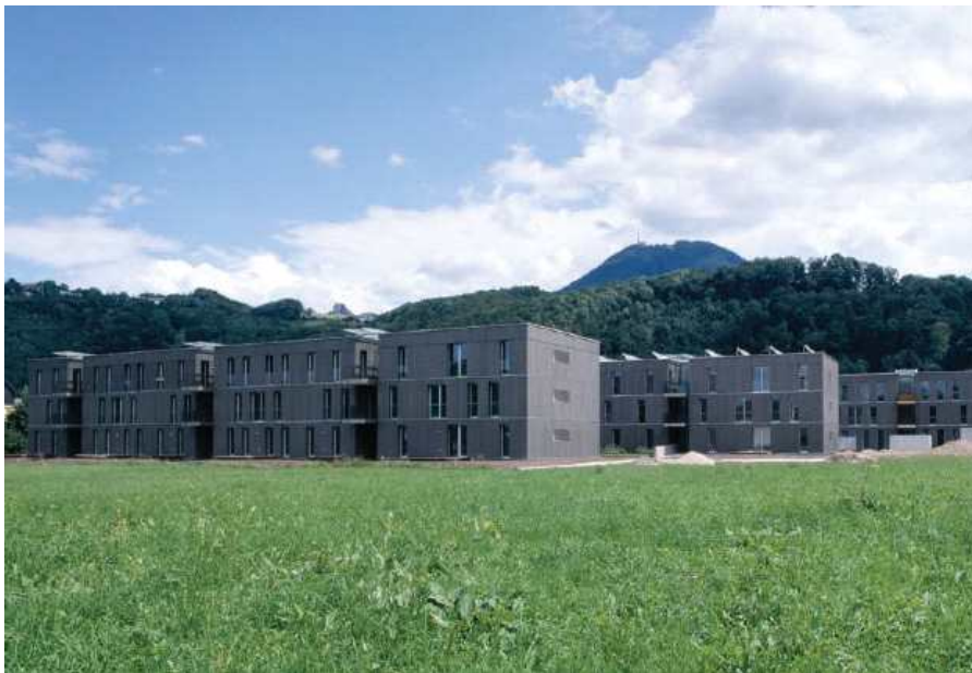
[그림4-71] 싸머 뢰슬(Samer Mösl) 단지 - 중앙건물 지붕에 태양열판 설치
