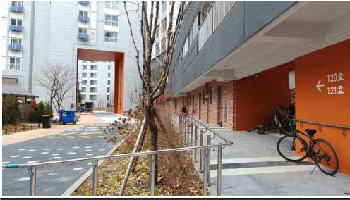
[그림4-46] 저층부 주거약자용 주택 세대 진입부
