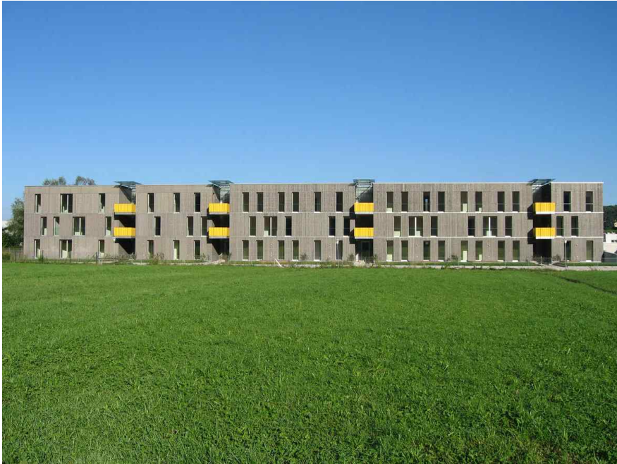
[그림4-71] 싸머 뢰슬(Samer Mösl) - 세대 사이에 설치된 발코니 로지아
