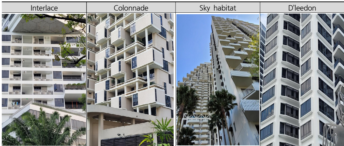
[표 4-11] 싱가포르 공동주택 입면 시공 사례
