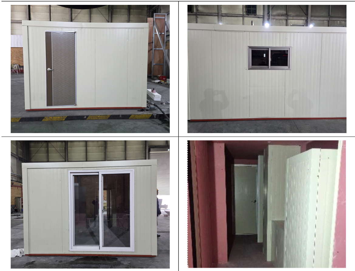
[그림 4-4] 출입문 및 가구류 등 시공사진
