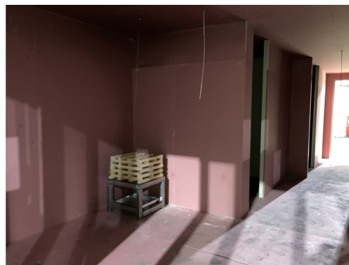
[그림 4-14] 거실 내 목재화원 설치
