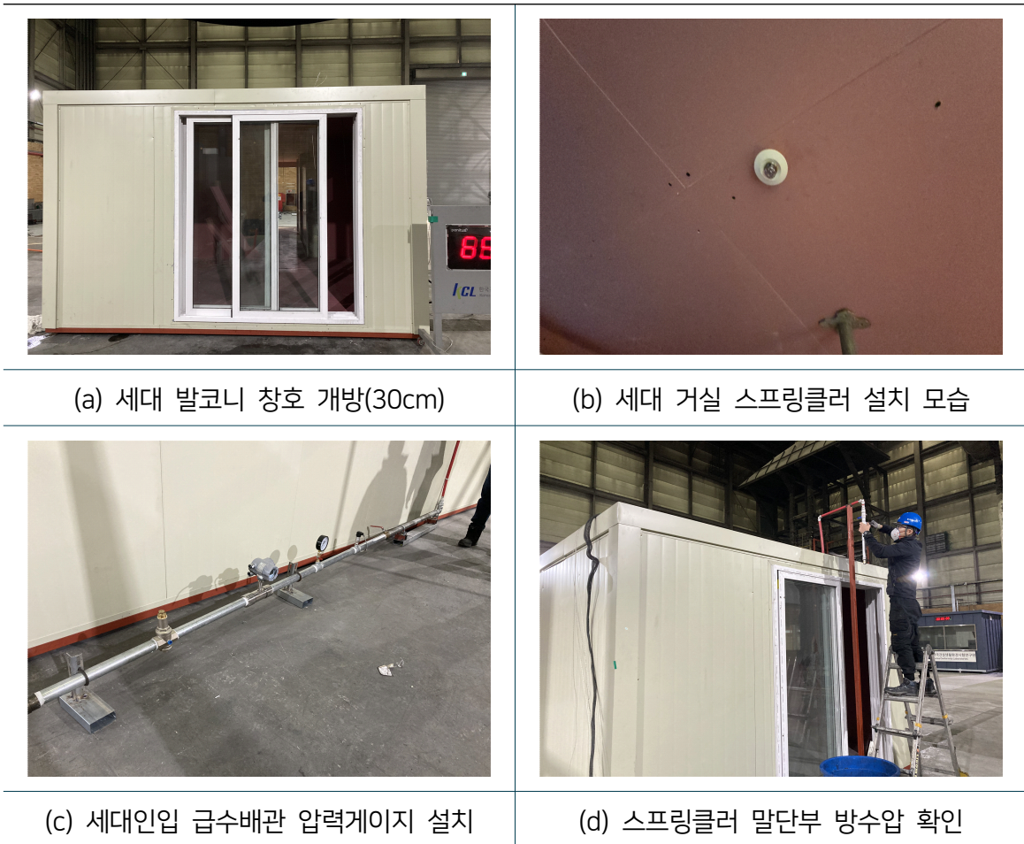
[그림 4-17] 실화재 시험용 스프링클러 설치
