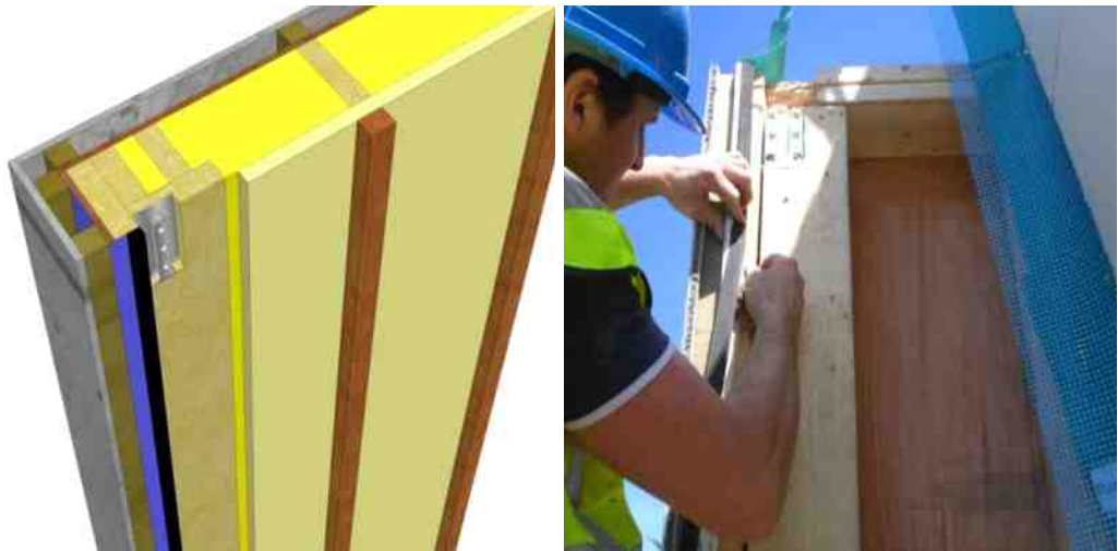
[그림 2-89] 기성 철물 Sherpa를 이용한 외벽패널 간 수평방향 접합
