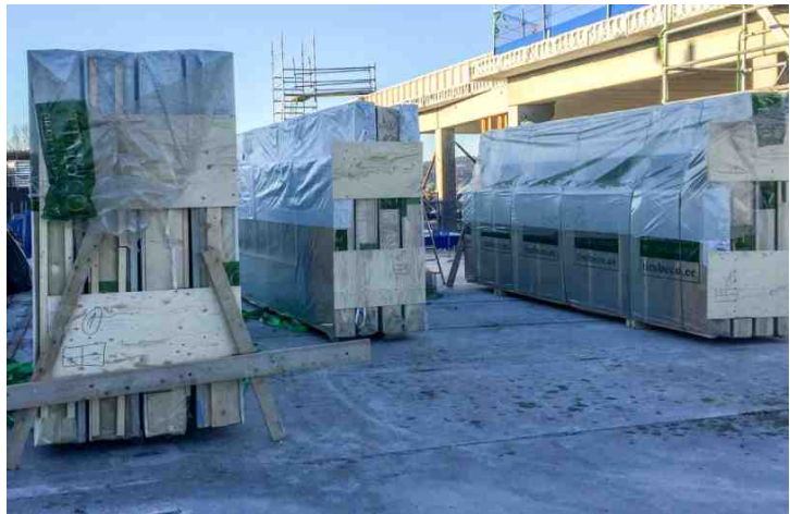
[그림 2-93] 창호와 마감재 파손방지를 위한 임시보강재 설치 예시
