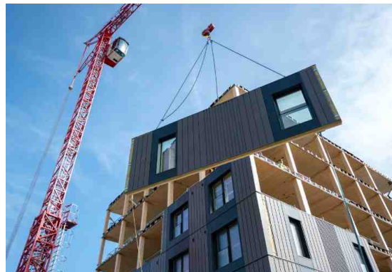
[그림 2-30] Halsä CLT 클로즈드 패널 현장양중 (1) (자료 : Intelligent City)
