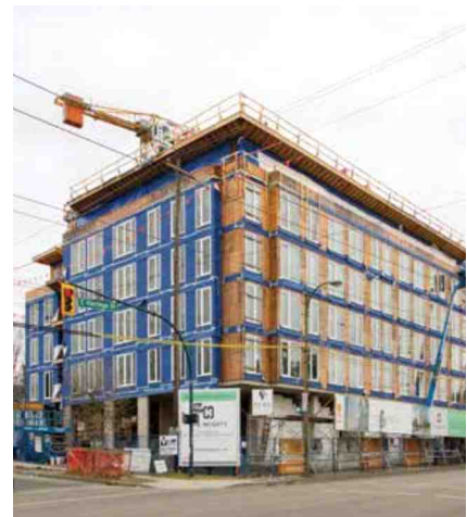
[그림 2-24] 투습방수지 시공 전경 (자료 : Passivehouse Canada)
