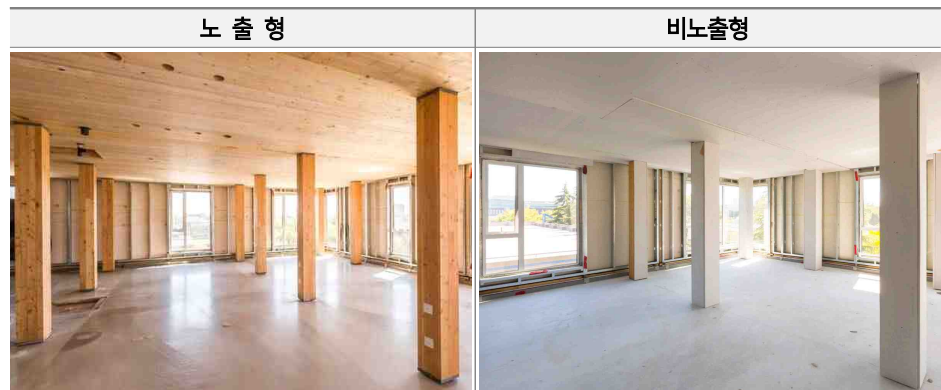
[그림 3-10] CLT 패널하부 노출형과 비노출형
