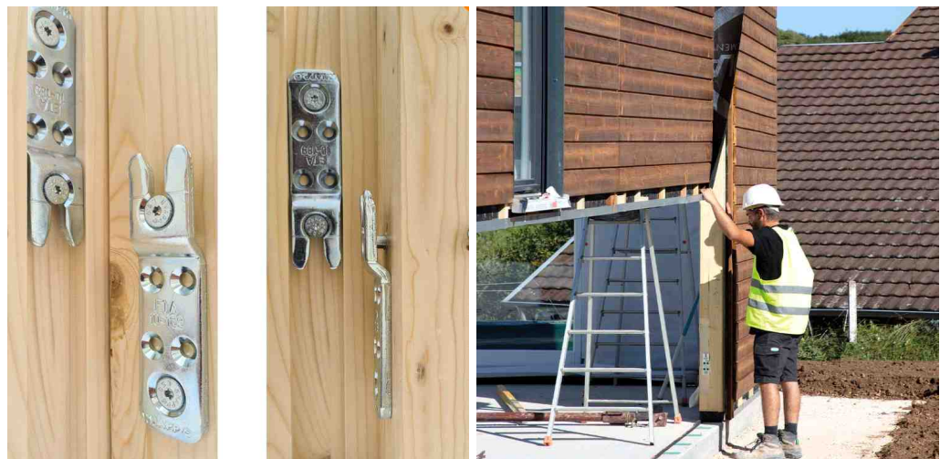
[그림 2-90] 기성 철물 Knapp를 이용한 외벽패널 간 수평방향 접합
