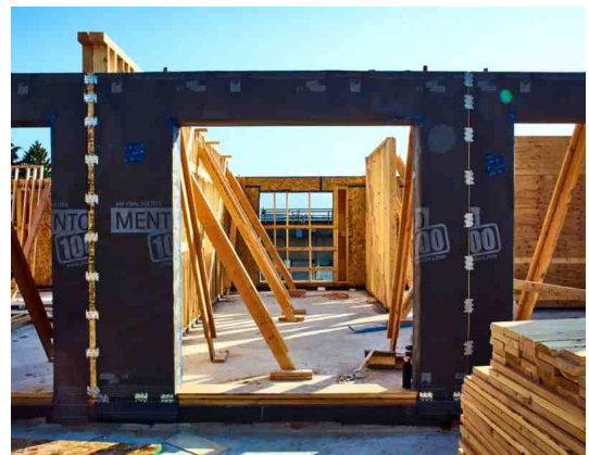
[그림 2-16] 현장 패널설치 전경 (자료 : Naturally)
