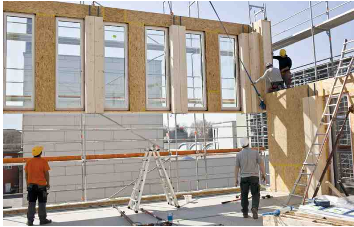
[그림 2-38] LCT one 패널 현장 양중 및 조립 (자료: CREE)
