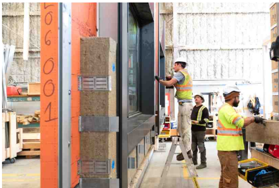
[그림 2-29] Halsä CLT 클로즈드 패널 단열재·창호시공 (자료 : Intelligent City)
