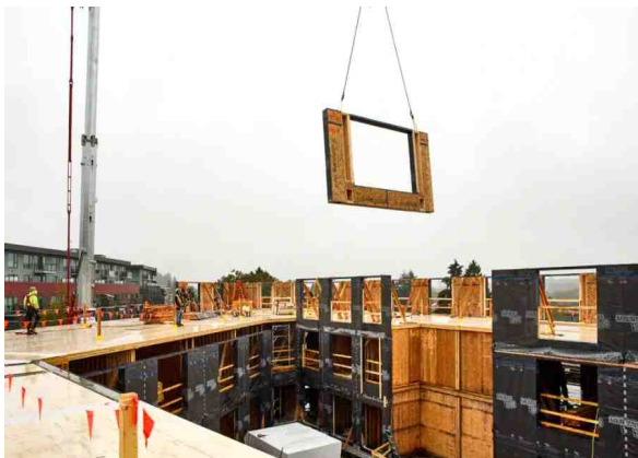
[그림 2-15] 현장 패널양중 전경 (자료 : Naturally)
