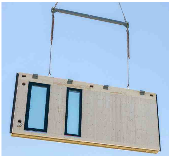
[그림 2-31] Halsä CLT 클로즈드 패널 현장양중 (2) (자료 : Intelligent City)
