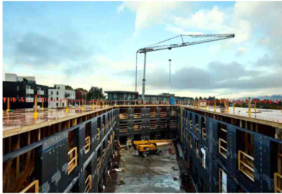
[그림 2-17] 현장 패널조립 전경 (자료 : Naturally)
