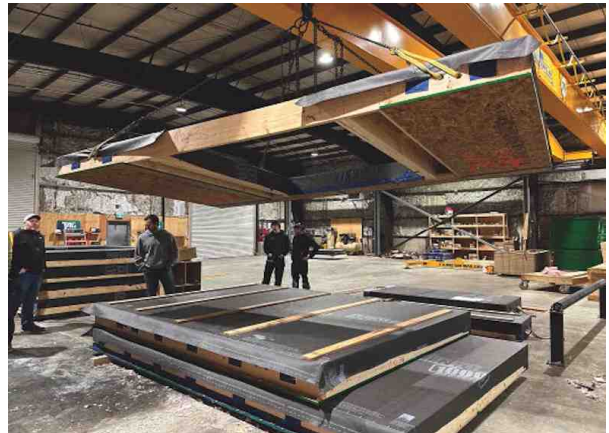
[그림 2-14] 클로즈드 패널 제작 전경 (자료 : TAG Panels)
