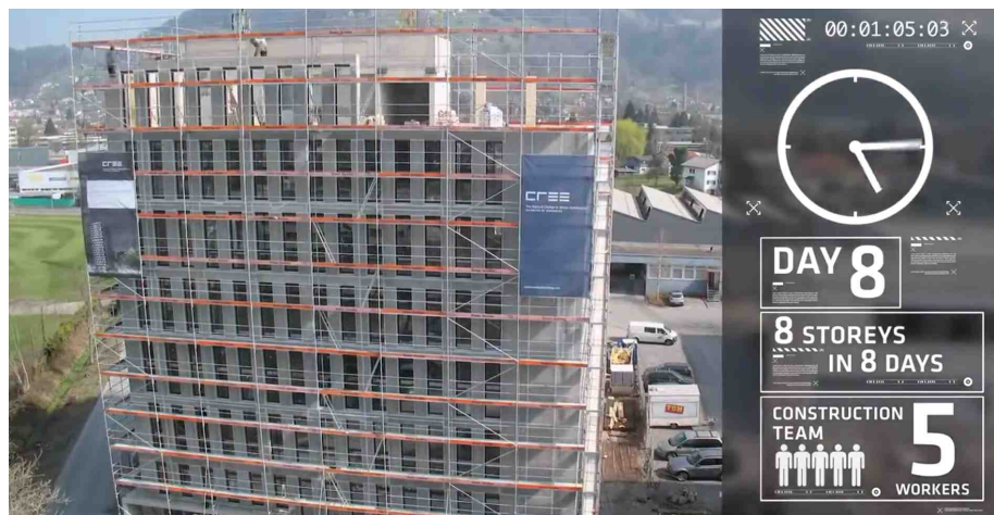
[그림 2-40] LCT one 골조조립 타임랩스 완료 8일차 (자료: CREE)
