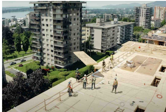
[그림 2-26] Crest CLT 바닥시공 전경 (자료 : Adera)
