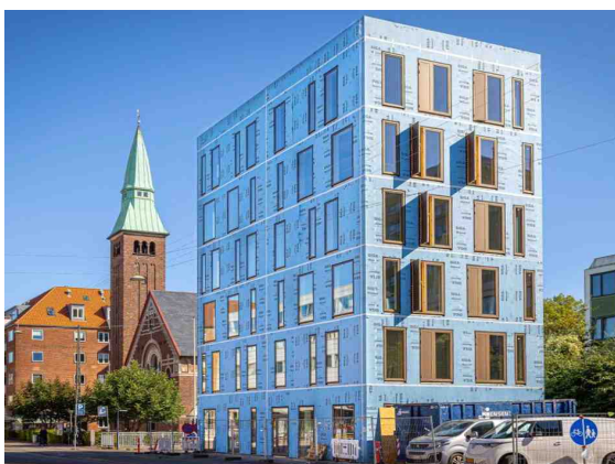
[그림 2-36] Østerbrogade 골조 시공 (자료 : kraer)
