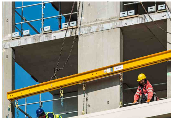
[그림 2-43] Doktoren 패널 고정용 앵글 브라켓 설치 전경 (자료 : MBS)
