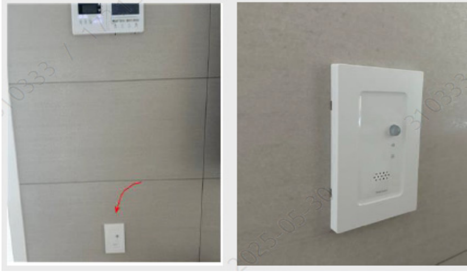
[그림 2-5] 층간소음 예방 시스템 적용 예(신축주택)(자료: LH공공주택시설처)
