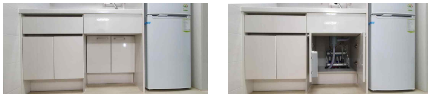
[그림 8-5] 온수분배기 앞 수납공간을 제거하여 주거약자의 이용 편의성 제고(청주개신 행복주택)
