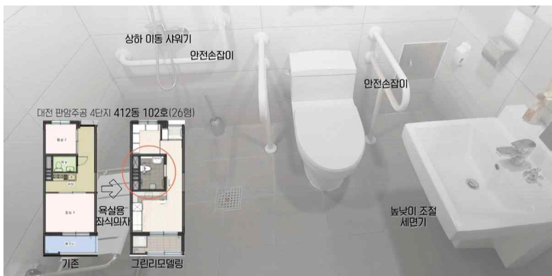
[그림 4-3] 대전 판암주공 4단지 26형 그린리모델링 후 개선된 화장실 모습
