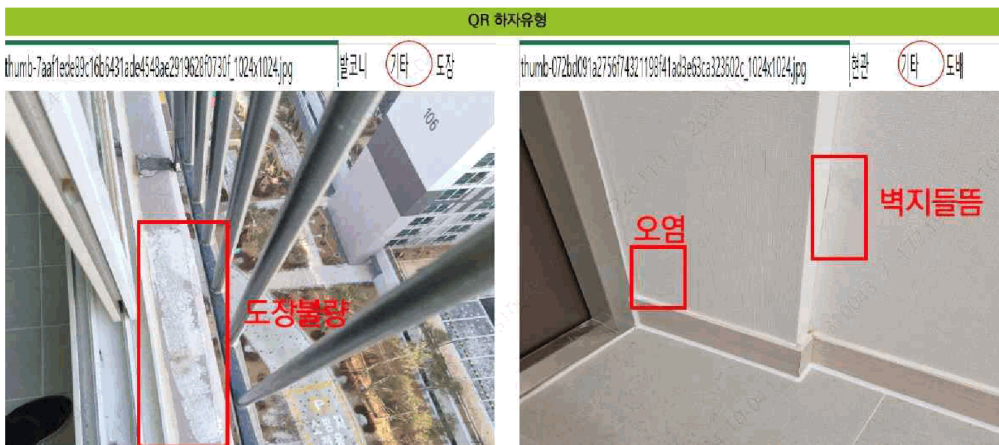
[그림 3-2] 하자 유형 임의 분류 및 육안 확인 어려운 이미지의 예(참고: (양동석, 2024))
