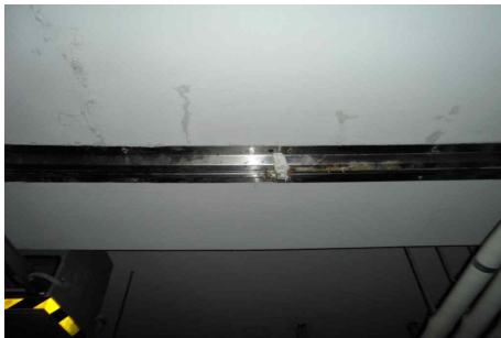
[그림 F-1] E/J 부위 발포성우레탄 보수 후 재누수 발생
