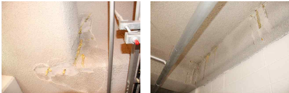
[그림 H-1] 발포우레탄 보수재 및 아크릴 보수재 보수 후 비교
