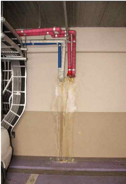
[그림 B-1] B단지 발포우레탄 누수부위 재누수 발생
