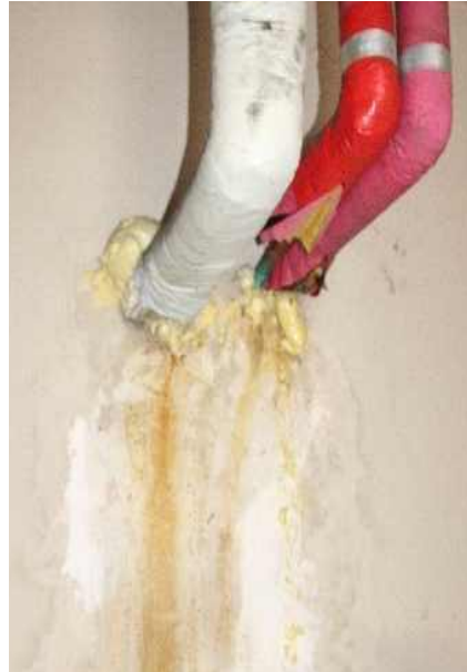
[그림 B-1] B단지 발포우레탄 누수부위 재누수 발생
