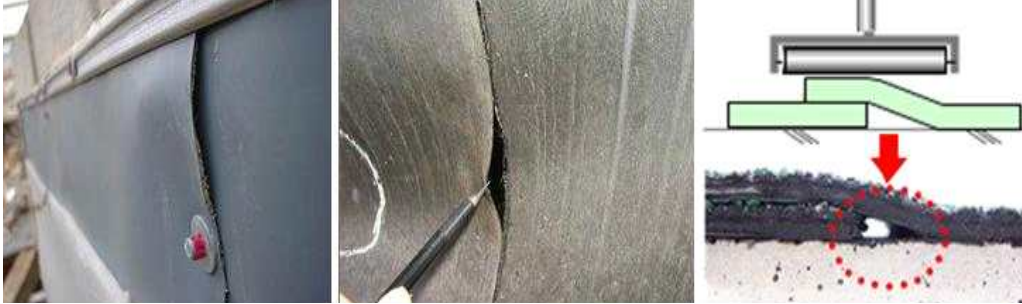
[그림 4-4] 수직부위 시트방수 접합부 손상 사례 및 시트방수 접합부
