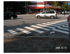
대기공간 안전시설 미흡(분당)
