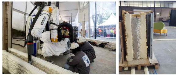
(a) 단열채+구조체 벽체 시공 (YHNOVA House, 2018) (b) 낭트대학교의 Batiprint3D 3D Printer 및 출력물 단면
