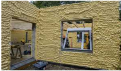
(a) 단열채+구조체 벽체 시공 (YHNOVA House, 2018) (b) 낭트대학교의 Batiprint3D 3D Printer 및 출력물 단면
