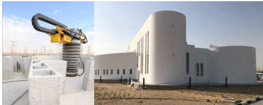
[그림 3-32] 이동형 크레인 타입 3D 프린터 및 세계 최대 규모 3D 프린팅 출력물
