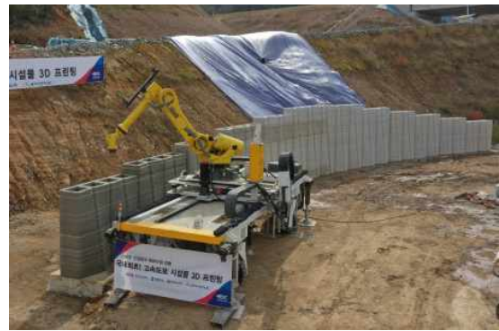
(b) 도로공사 옹벽 3D 프린팅 시공(2023)
