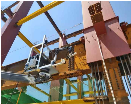
[그림 3-22] 삼성물산 철골 볼트 조임 자동화 로봇(좌), 호반건설 × WPS - 외벽 도장 로봇 'Rollot' (우)
