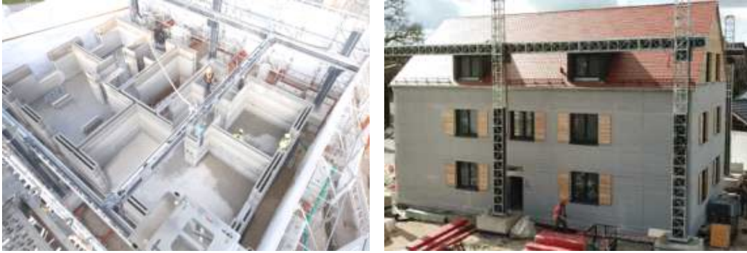
[그림 3-29] COBOD 프린팅 장비 및 3층 규모 임대용 아파트 출력
