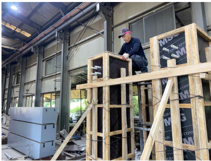
(i) 기둥 상부 인서트 설치
