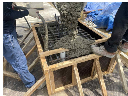
(b) 기초 콘크리트 타설
