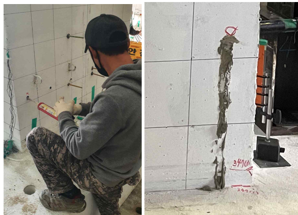
[그림 3-8] 에폭시 주입제를 이용한 보강
