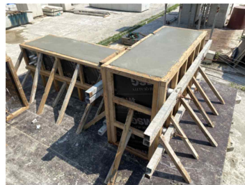
(b) RC 콘크리트 타설
