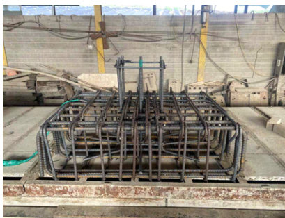
(a) 기초 철근 배근
