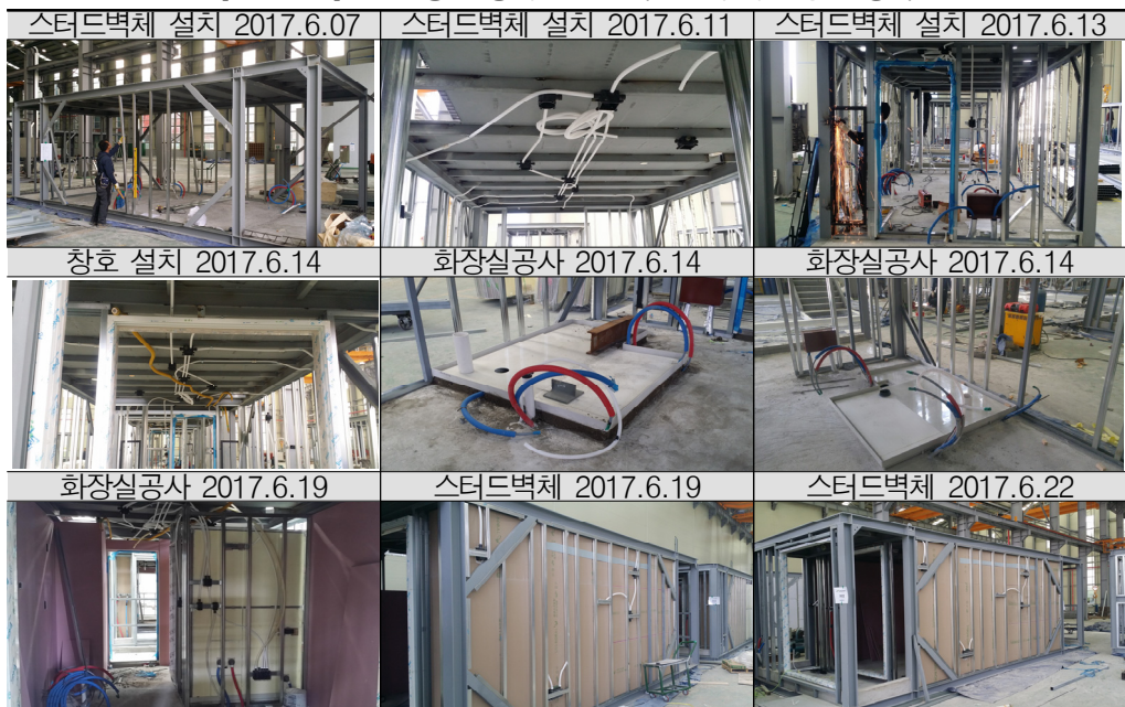
[표 2-10] 부산 용호 행복주택 스테드벽체/욕실/창호 공사
