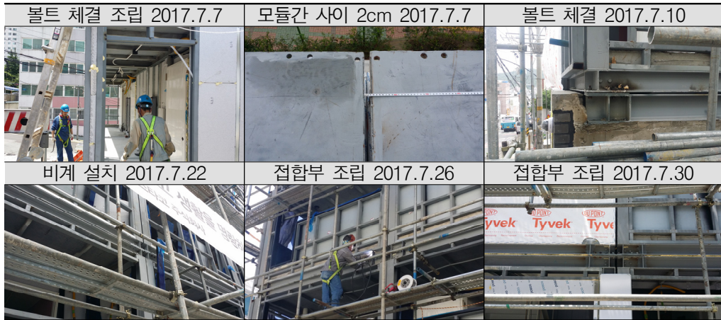
[표 2-15] 부산 용호 행복주택 현장공사
