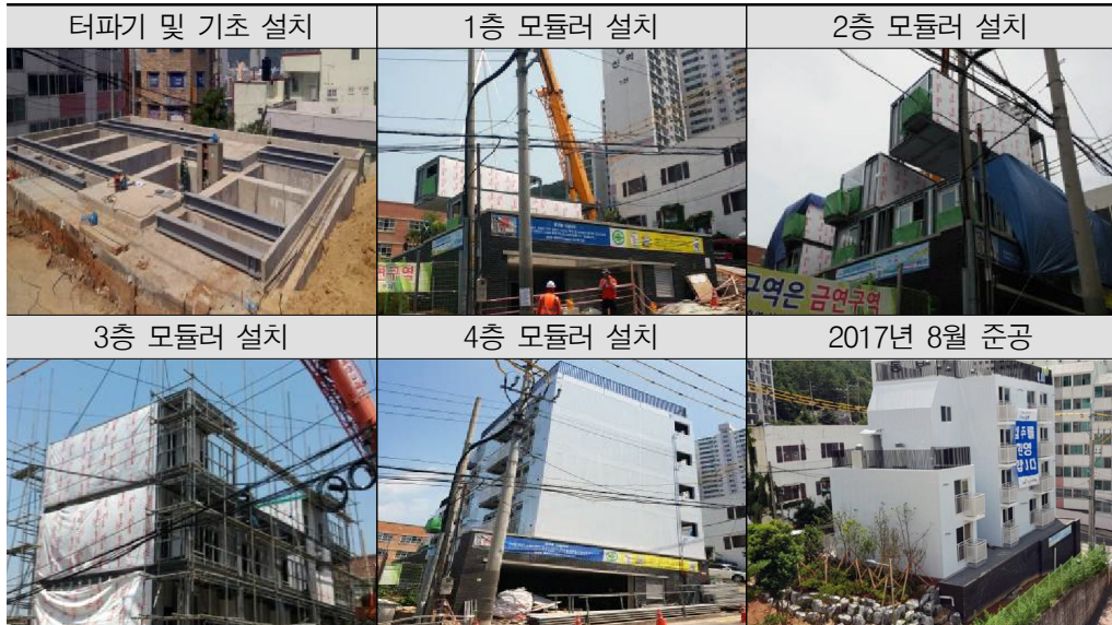
[표 2-6] 부산 용호 행복주택 적층 공법 설치 공정 사진
