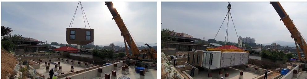
[그림 2-8] 세종형 사랑의 집짓기 모듈러 양중 및 설치 현장사진
