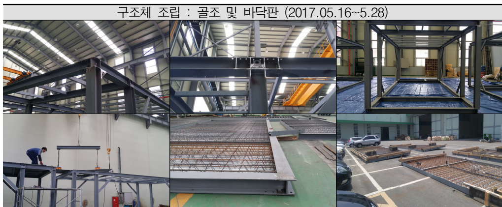
[표 2-8] 부산 옹호 행복주택 구조체 조립 과정
