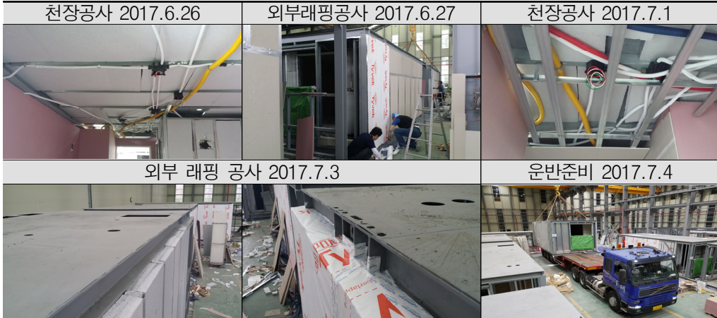
[표 2-13] 부산 용호 행복주택 천장/외부 래핑 공사
